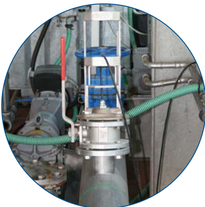
Abb. 3: SOLITAX highline sc in Rohrleitung eingebaut
